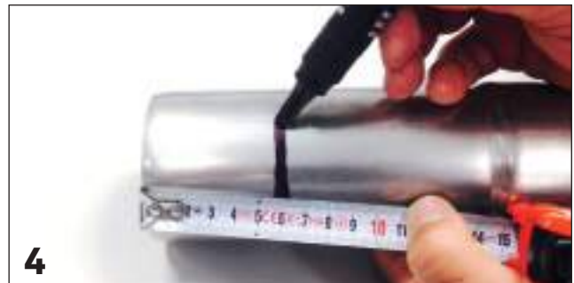
Marcatura quota d'innesto / Marking the insertion's depth
